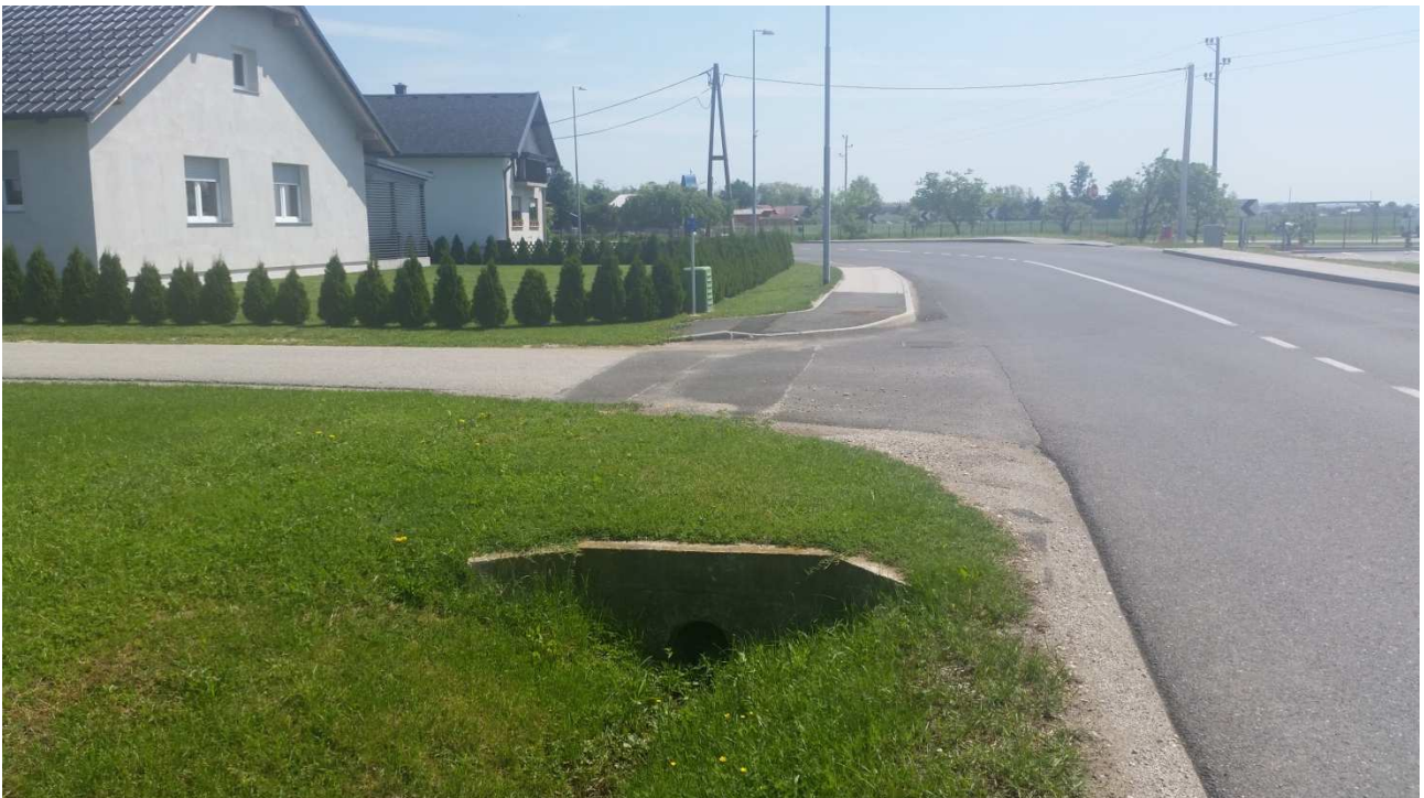
Slika 3: Prikaz obstoječega prepusta pri začetni stacionaži kolesarske poti ter navezava na obstoječo meteorno kanalizacijo v km 0.5+159:
